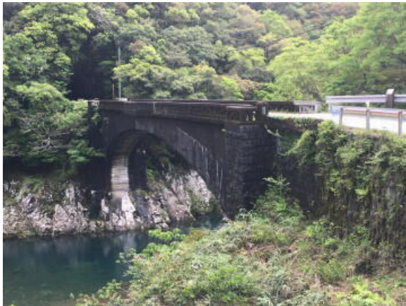
3.堀ヶ生橋:47mの鉄筋コンクリートアーチ橋。鉄筋と言っても線路として使用するレールが入っているようですが、フォルムが美しく、河川敷に降りて見上げました。
