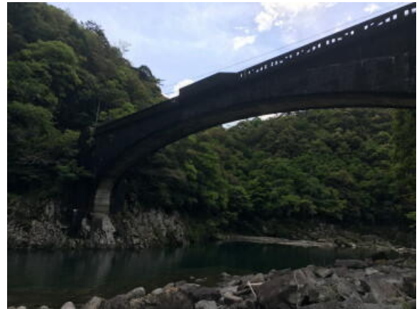
3.堀ヶ生橋:47mの鉄筋コンクリートアーチ橋。鉄筋と言っても線路として使用するレールが入っているようですが、フォルムが美しく、河川敷に降りて見上げました。
