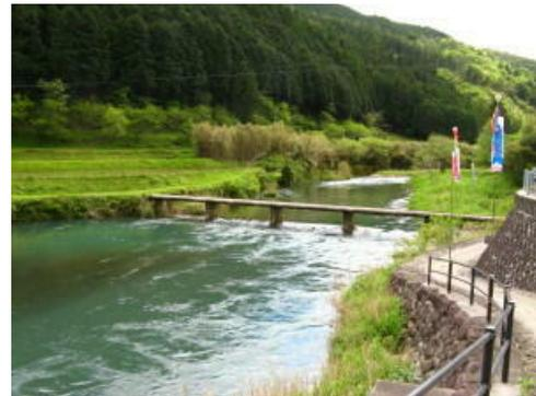
ルーツとなるのは、支川の北川川に架かる早瀬の一本橋で、増水すればワイヤーでつないだ丸太の橋桁が流れる構造で、普通の状況に戻れば再生するから流れ橋と呼ばれています。橋は対岸との文化を融合させる効果がありますが、この橋を渡ると津野山神楽が開催される諏訪神社へのアクセス道路という役目も果たします。
